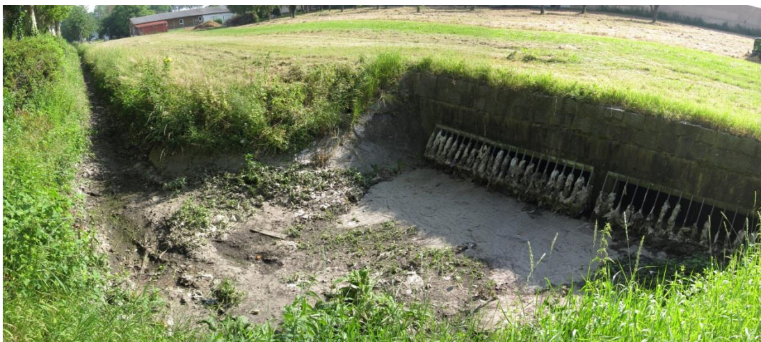
Abbildung 12: RÜB E3: Zwischenliegende Entlastung des Staukanals
