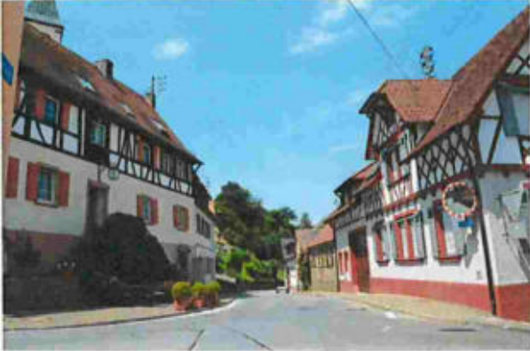
Gebäudegruppe in der Winterstraße
